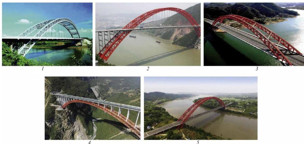
Рис. 2. Мосты из трубобетона в Китае [1]
