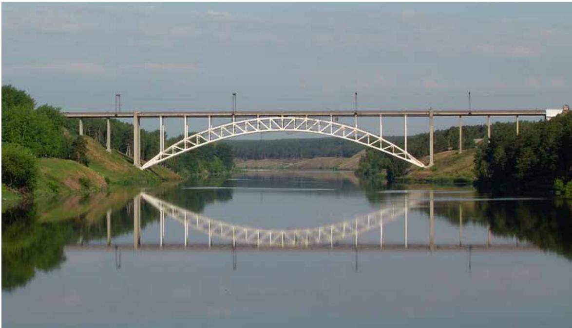
Рис. 1. Арочный мост из трубобетона в Каменск-Уральском (Свердловская обл.)
