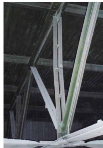
Рис. 1. Деформация сжатой стойки из плоскости фермы
