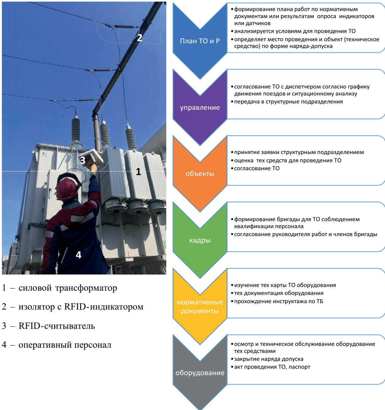
Рис. 3. Применение системы контроля и учёта объектов технической эксплуатации
